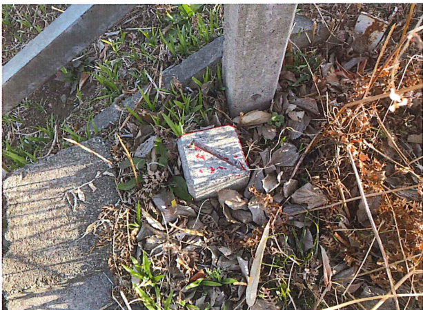
画像資料 NOK9 摘要 コンクリート杭
