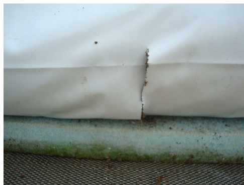
写真 3-7 : 排水溝切り込み後
