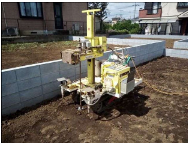
<調査風景(測点02)>
