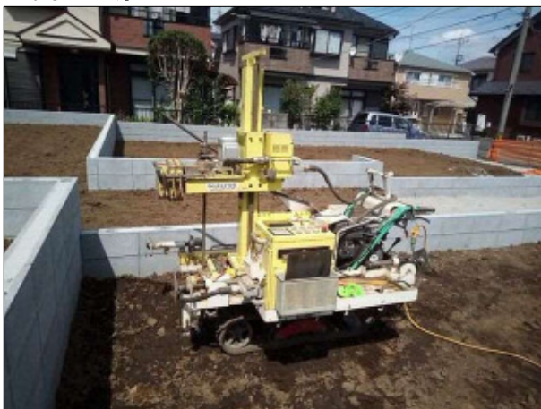
<調査風景(測点03)>
