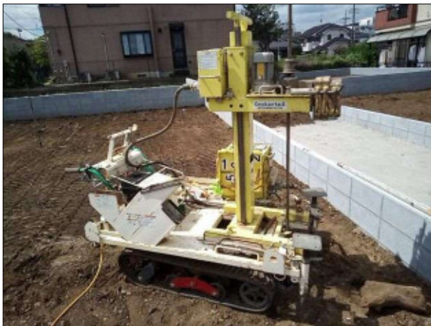
<調査風景(測点01)>
